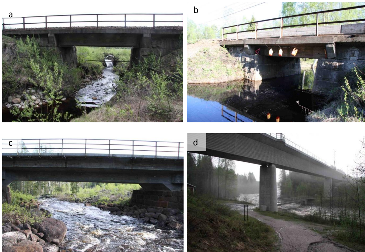
Figur 7. Exempel på broar som behöver respektive inte behöver åtgärdas. a) Bro (1886) med strand som behöver bättras på så att den är torr vid högvatten. b) Bro (1880) där vattendraget är rakt och har lugnt flöde och som inte behöver åtgärdas, men som inte heller är bra för utter eller annat småvilt. c) Bro (1879) med stränder under båda sidorna, vilka klarar högvatten (som här) och därmed inte behöver åtgärdas. d) Landskapsbro (1869) som är bra utformad för utter och inte behöver åtgärdas. Foto: J Arrendal, MyraNatur.
