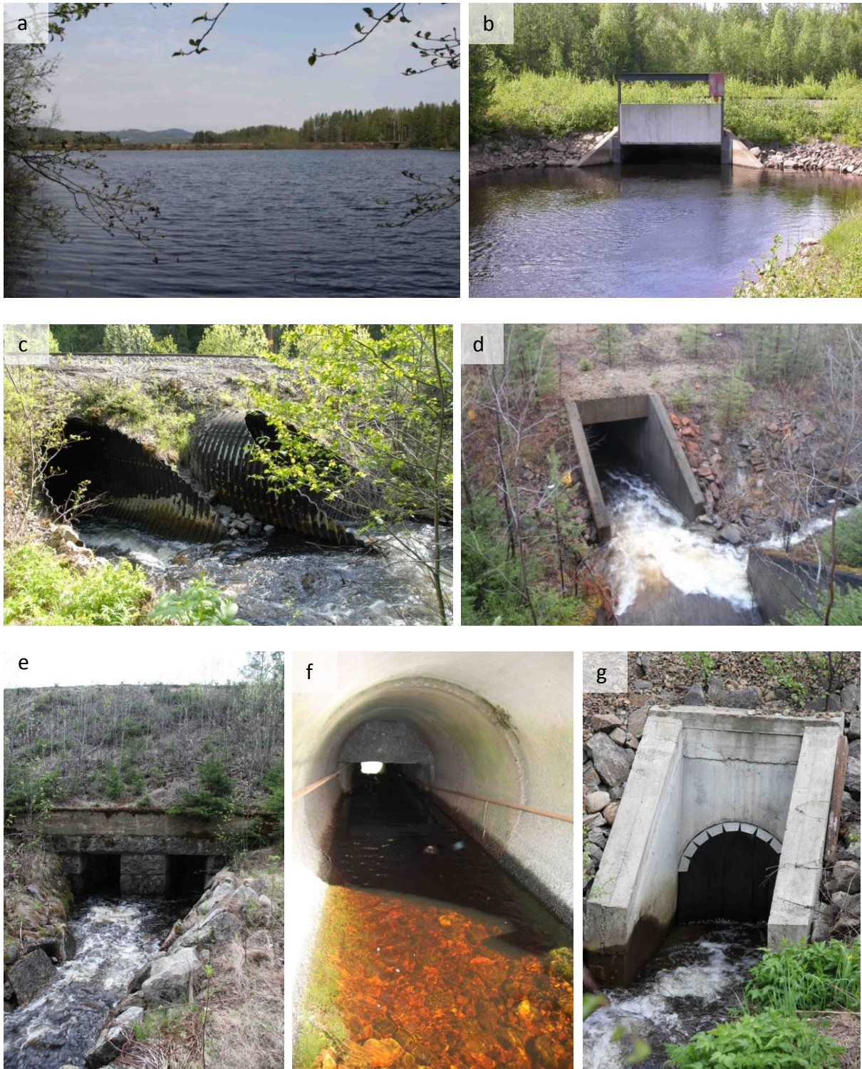
Figur 6. Exempel på broar och trummor som behöver åtgärdas. a) Banvall över sjö med bro (1857) i ena änden. b) Dammreglering i samband med bron (1772). c) Rörbroar med hög strömningshastighet (1756). d) Större kulvert (1597) med hög strömningshastighet. e) Stensatt mindre kulvert (14432) med hög strömningshastighet. f) Stensatt kulvert (4124) förlängd med trummor, översvämmas lätt. g) Kulvert (13456) med sk köldridå, hög strömningshastighet. Foto: a, e-g: J Arrendal, MyraNatur; b-c: Erik Isakson; d: fotograf okänd, ur BaTMan.
