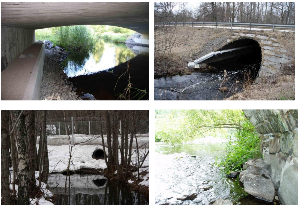
Figur 4. Exempel på åtgärder för utter: a) konstgjord strand, b) hylla, c) torrtrumma och stängsel och d) markeringsstenar. Foto: J Arrendal, MyraNatur.
