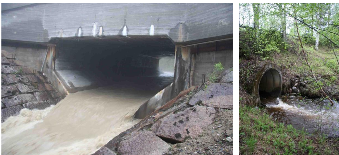
Figur 8. De två objekt som utgjorde vandringshinder för fisk. Bro 1867, Björnabäcken, och trumma 1965, Degerbäcken. Foto: J Arrendal, MyraNatur.
